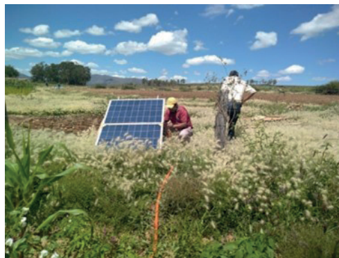
Panneau solaire en Bolivie
